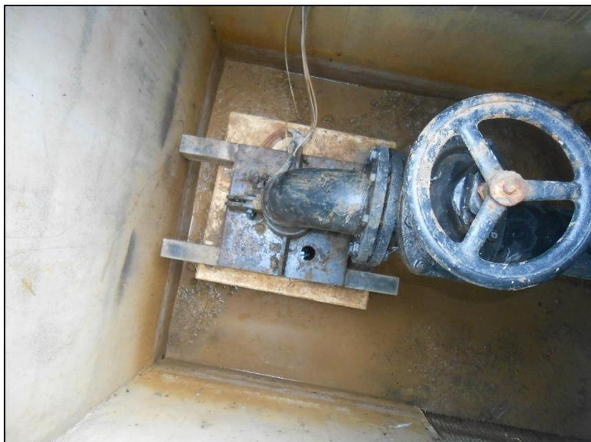
Photo 3 : Un des deux forages dans la chambre de captage
