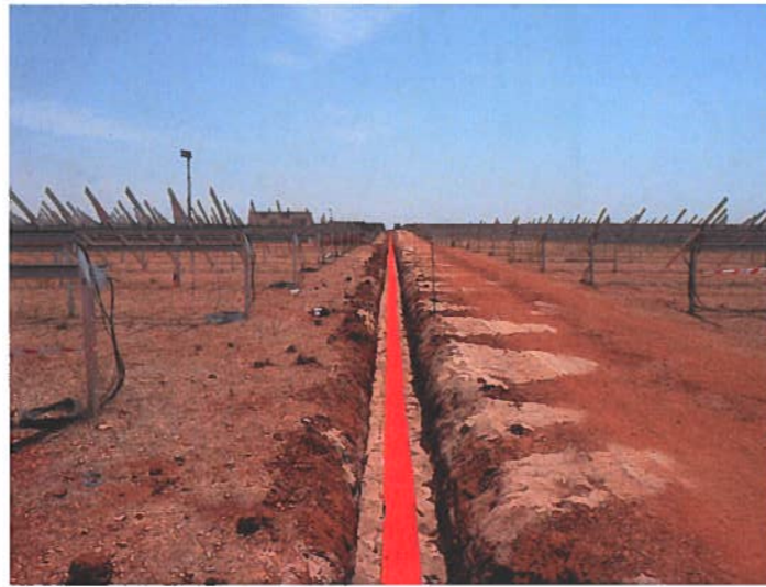
Pose des structures porteuses et raccordement interne
