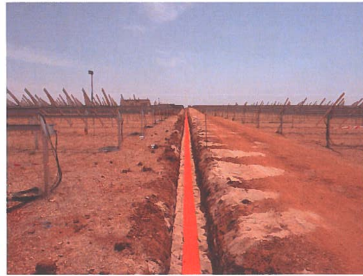
Pose des structures porteuses et raccordement interne
