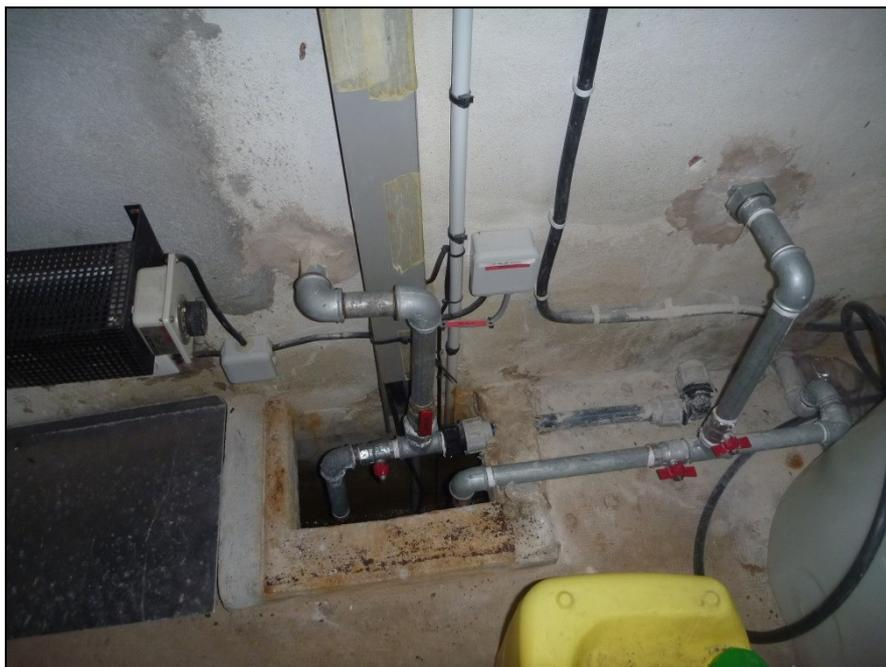
**PHOTOGRAPHIE 3 : ARRIVEE DES EAUX DU CAPTAGE DES LAVANDES DANS LE RESERVOIR COMMUNAL**
