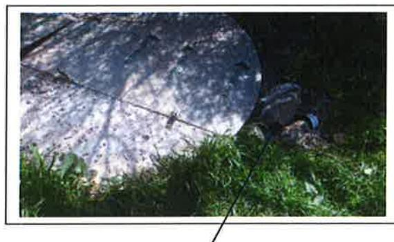
Le trop plein du digesteur s'écoule directement vers le ruisseau par un tube PVC.
