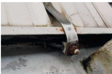
Figure 14 : Boucle extérieure de terre (existante)
