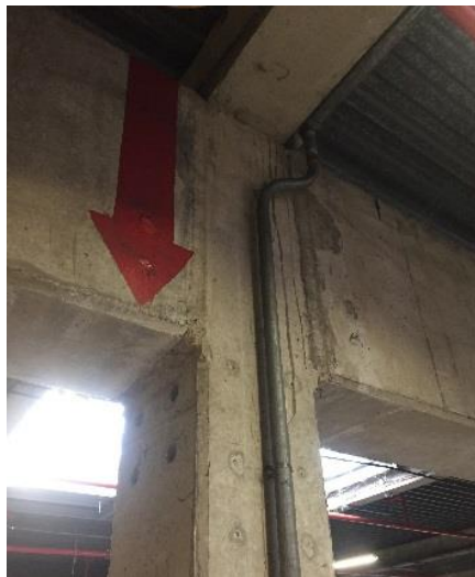
Figure 11 : Photo de la liaison poutre-poteau
