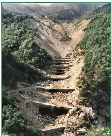
Les Conques : stabilisation de pied de la moraine du Canigou par barrages de correction torrentielle © RTM
