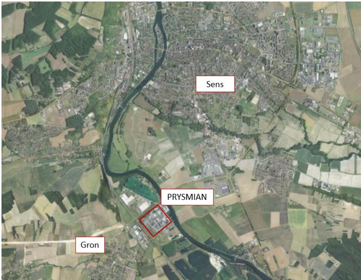
Figure 1 : Photo aérienne autour du site de PRYSMIAN (source : Géoportail, le 29/08/2022)
