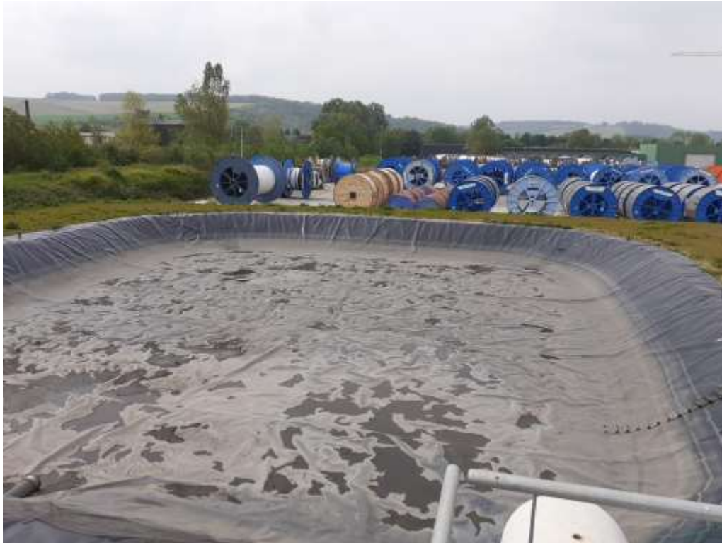
Figure 5 : Photo du bassin prise en mai 2023
