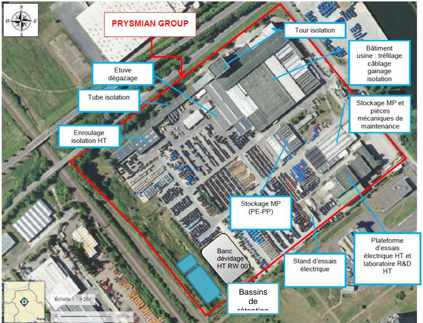
Figure 4 : Présentation du site (source : Bilan administratif des ICPE réalisé par SOCOTEC du 10/06/2022)
