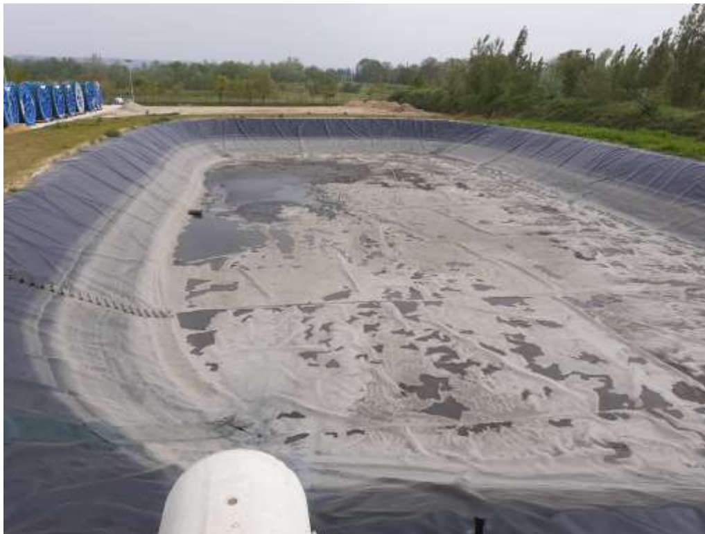
Figure 4 : Photo du bassin prise en mai 2023
