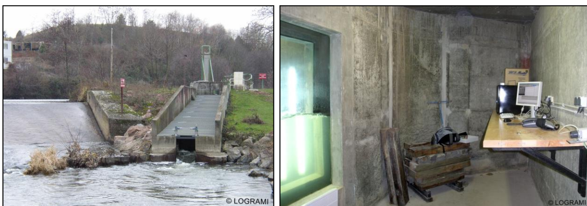
Figure 42 : Passe à poissons et salle de comptage du barrage des Forges (Source : ©Logrami)
