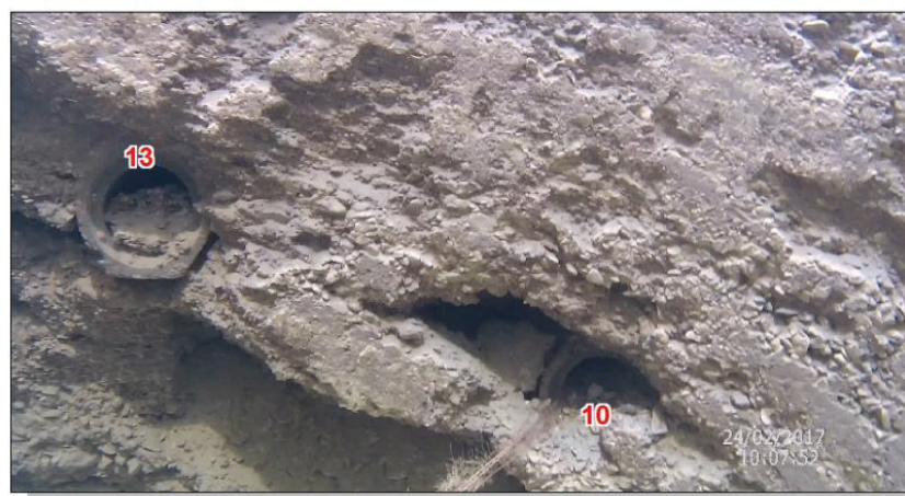
Vue sur les drains 13 et 10
