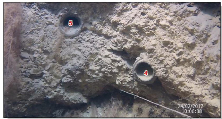
Vue sur les drains 5 et 4
