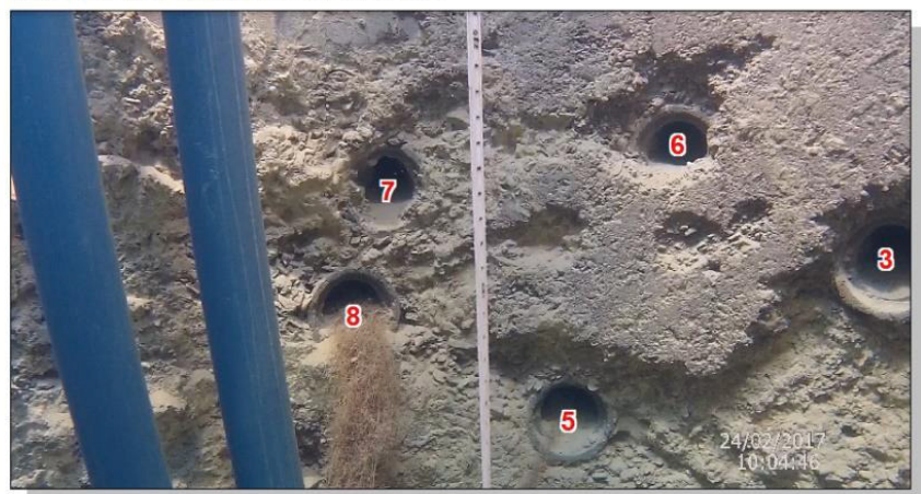
Vue sur les drains 7, 8, 5, 6 et 3
