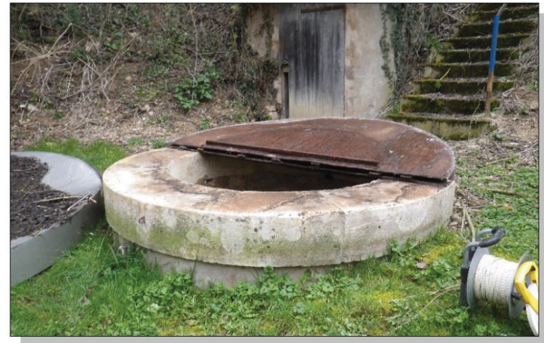
Vue extérieure de l'ouvrage
