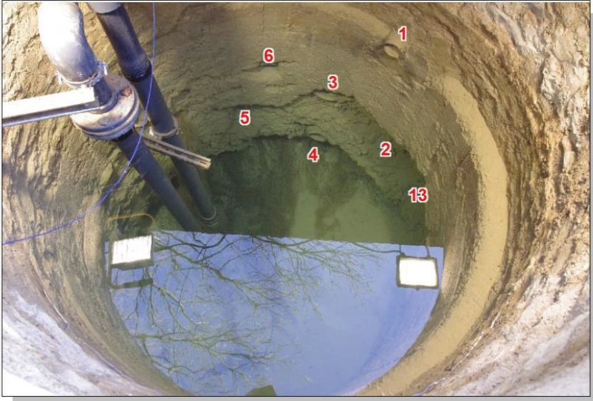
Vue intérieure de l'ouvrage
