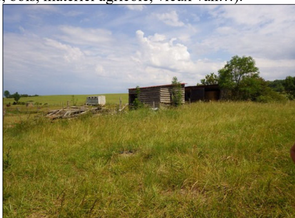
Photo 1: Constructions et dépôts sur la parcelle ZC 9
