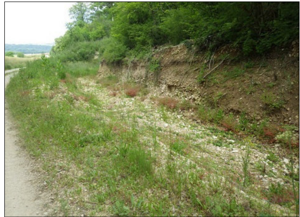
Photo 4: Fosse d'infiltration des eaux pluviales
