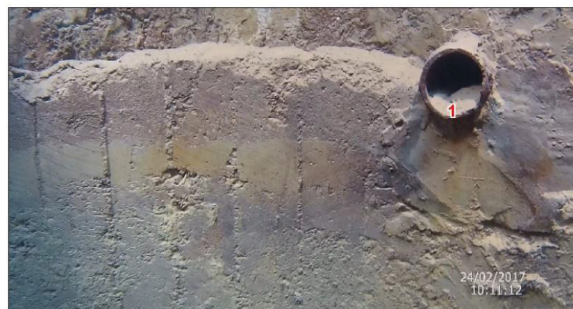
Vue sur le drain 1
