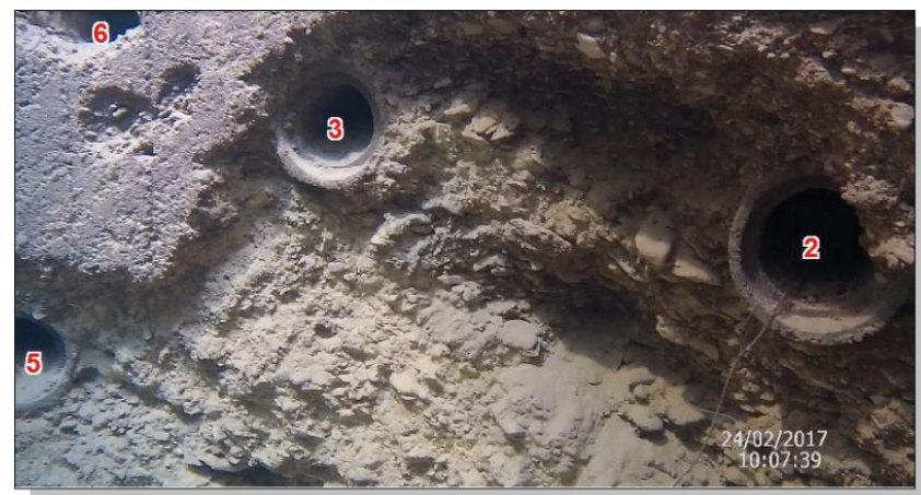
Vue sur les drains 5, 6, 3 et 2
