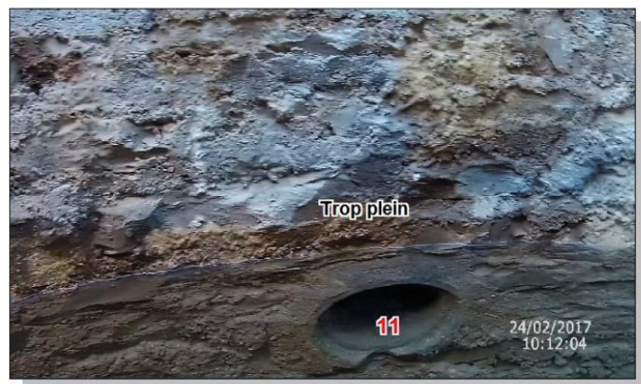
Vue intérieur de l'ouvrage
