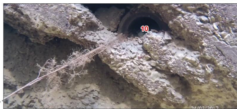
Vue sur le drain 10
