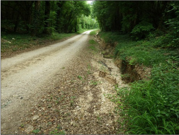
Photo 3: Érosion en aval des vignes
