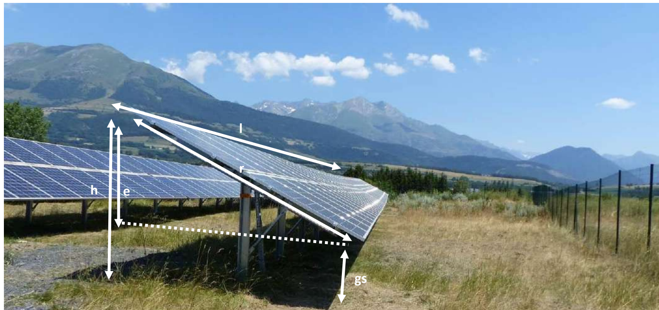
Figure 19 : Structure fixe exemple du parc de Susville 1 en Isère (© Corieaulys)
