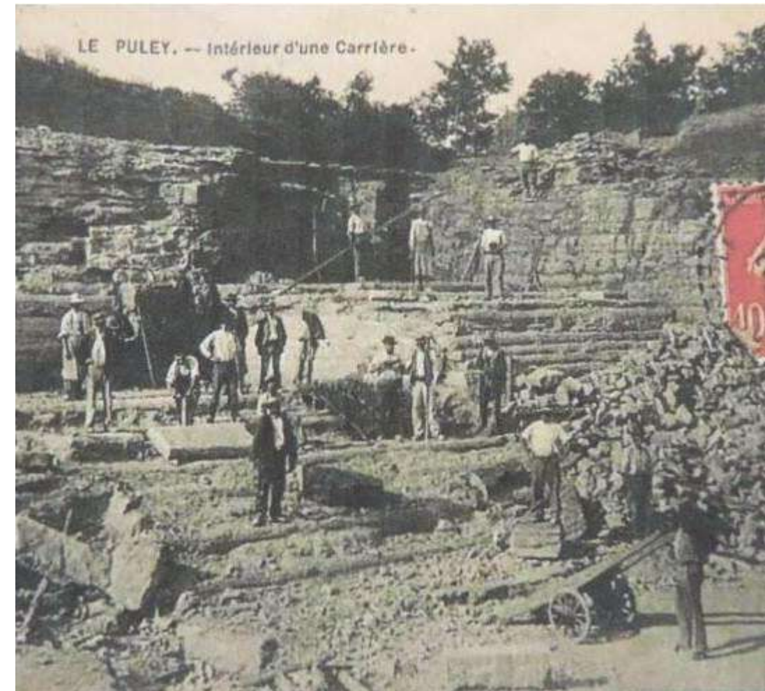
Figure 161 : Photographie ancienne de l'exploitation de la pierre blanche au Puley 141
