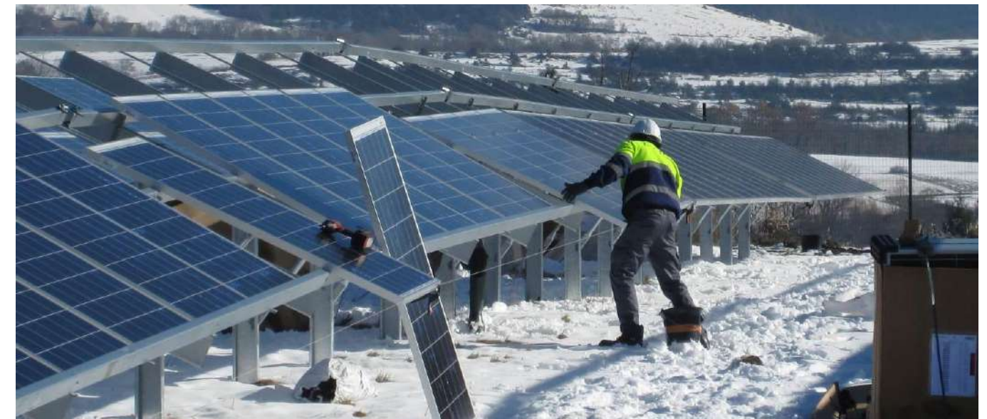
Figure 31 : Montage des modules (Susville 1 © GEG/CNR)
