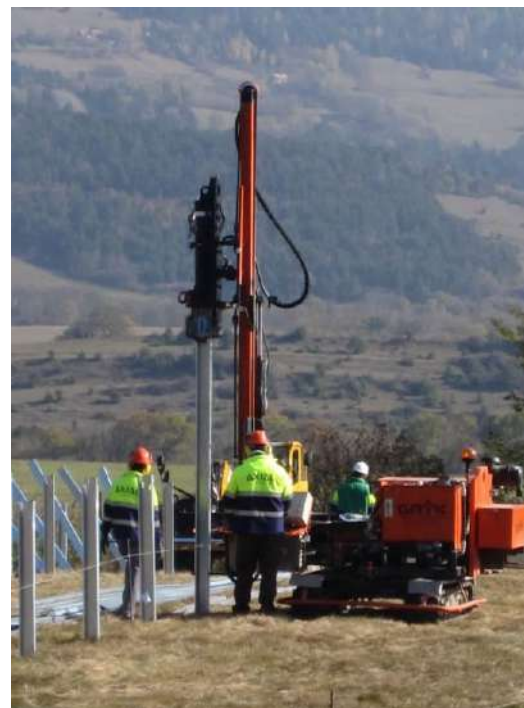
Carte 15 : Tranchées et battage des pieux (Susville 1 © GEG/CNR)-
