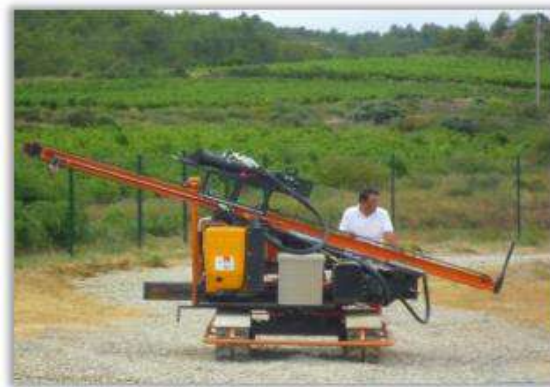
Machine de battage de pieux
