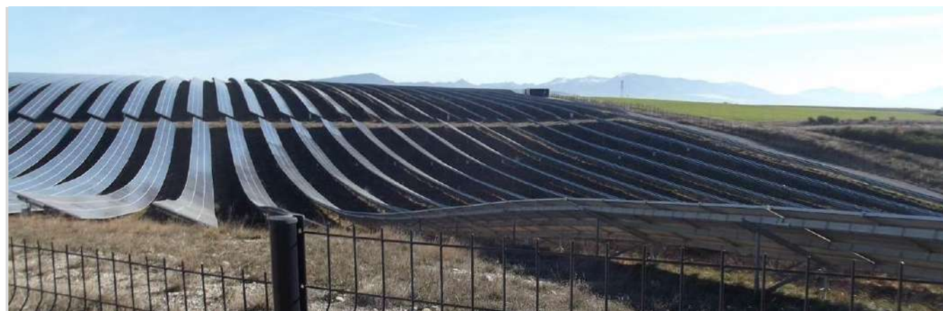
Figure 67 : Exemple de parc photovoltaïque au sol épousant les courbes de niveau (Alpes de Hautes-Provenances)
