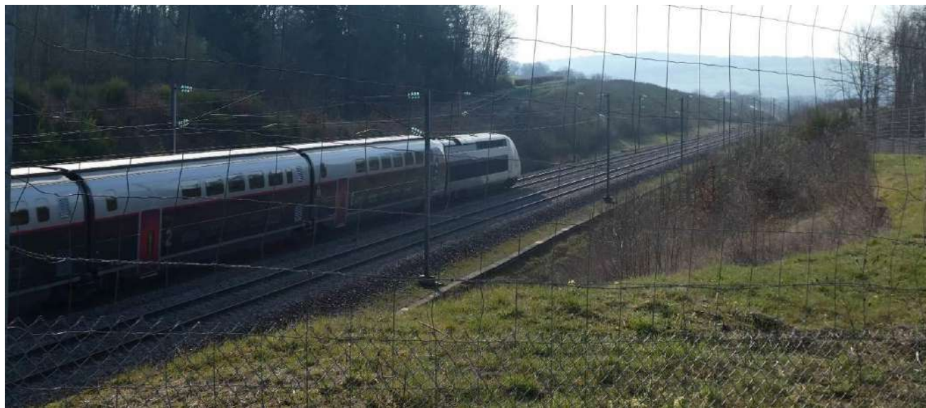
Figure 145 : Voie ferrée à proximité de la ZIP – LGV Paris-Sud-Est
