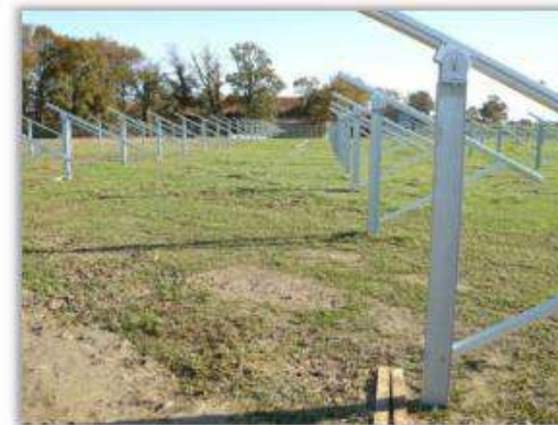
Structures ancrées par pieux battus
