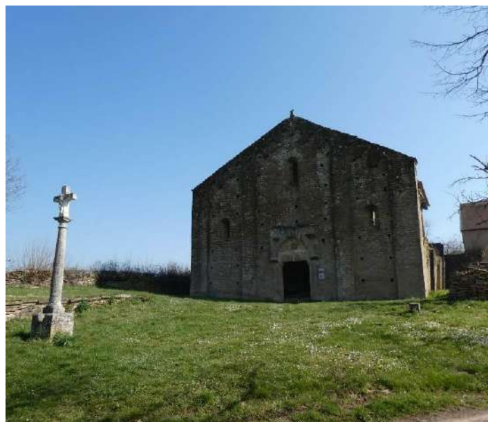
PDV 14 : L'ancienne église
