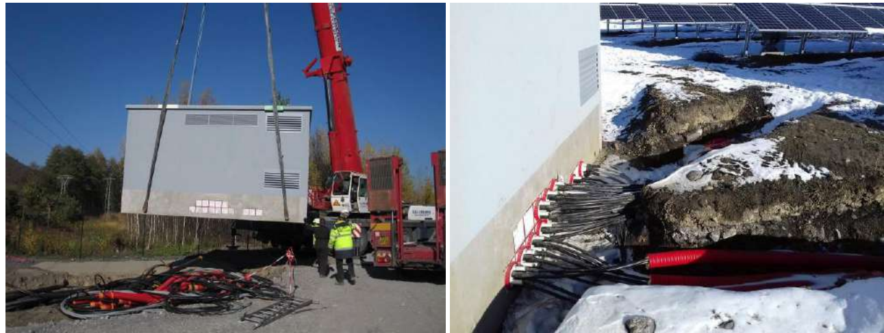
Figure 32 : Livraison, mise en place et câblage des postes (Susville 1 © GEG/CNR)
