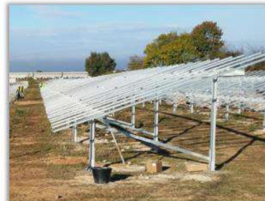
Structures ancrées par pieux forés
