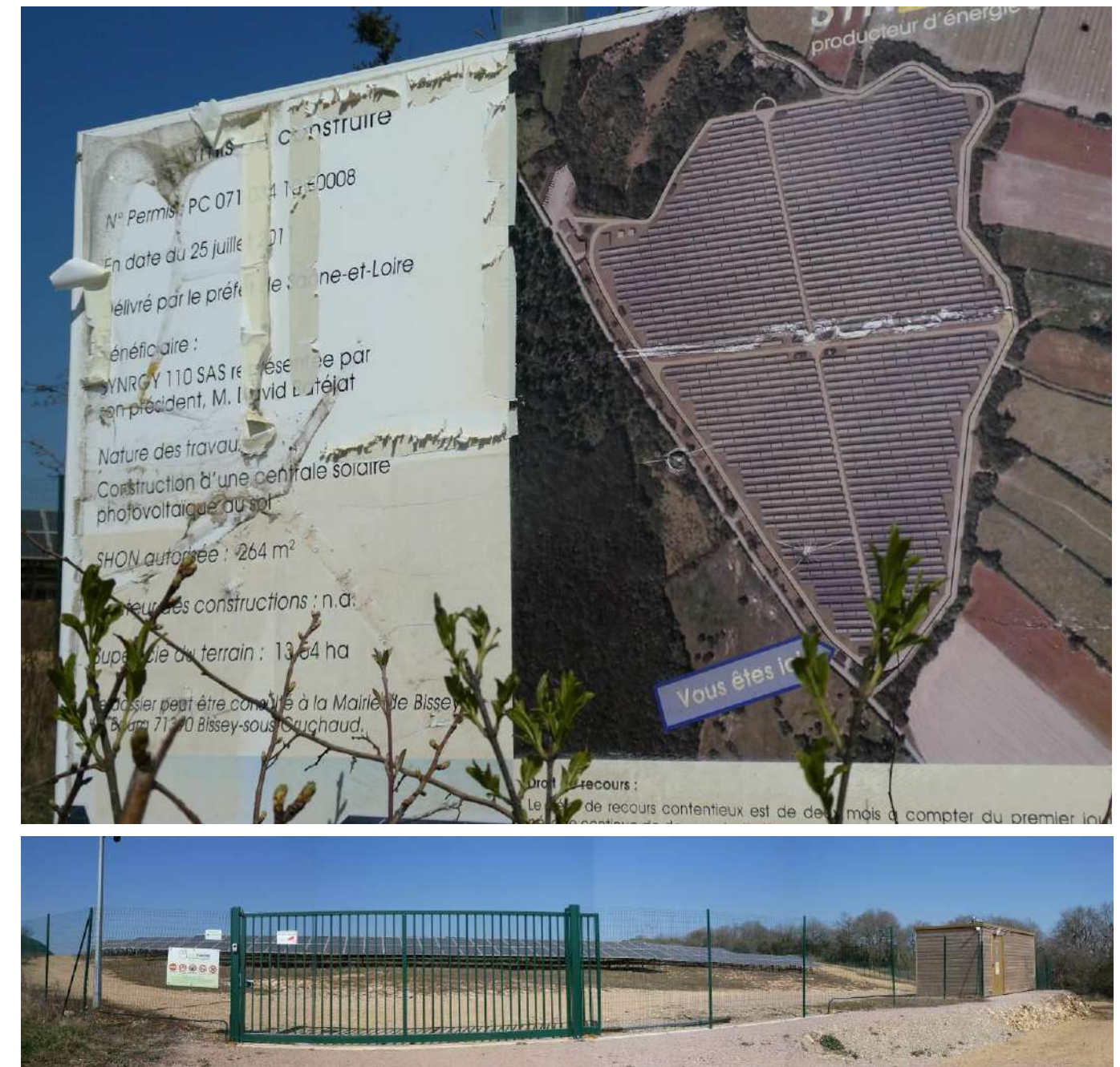
Figure 165 : Le parc photovoltaïque de Bissey-Sous-Cruchaud
