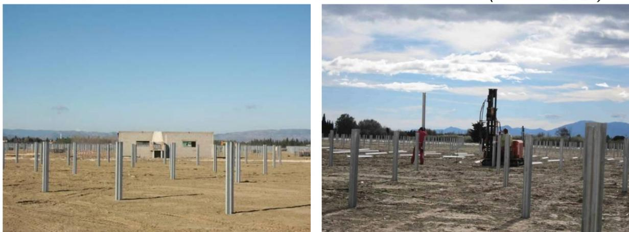
Battage des pieux sur le chantier de la centrale de Torreilles (source : NEOEN)
