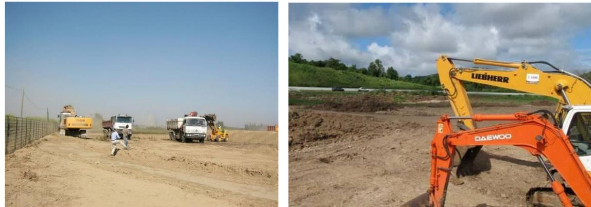
Opération de nivellement sur le chantier de la centrale photovoltaïque au sol de Torreilles (photo de gauche) et sur le chantier de la centrale de Ducos (photo de droite) (source : NEOEN)
