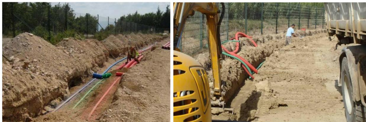
Réalisation des tranchées de la centrale photovoltaïque au sol de Lagarde-d'Apt (photo de gauche) et de Torreilles (photo de droite) - (source : NEOEN)
