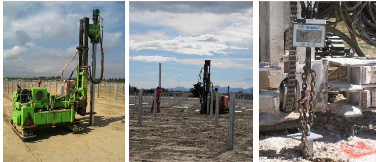
Photos 2 : Battage des pieux sur le chantier de la centrale photovoltaïque au sol de Torreilles (photos de gauche et au centre) ; Test d'arrachage des pieux vissés sur le chantier de la centrale de Lagarde-d'Apt, photo de droite (source : NEOEN)
