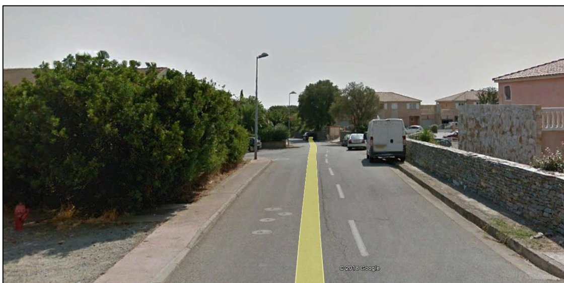
Figure 43 : Route de Petrelle – Absence de bande de stationnement
