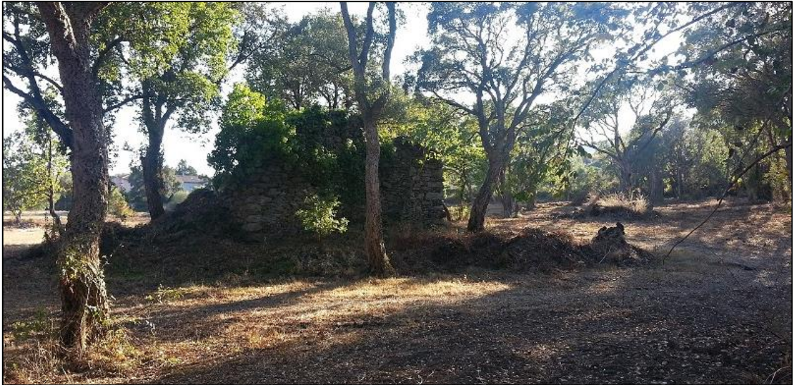
Figure 24 : Photo 9 – Ruine sur la parcelle B 1495 (T&D, 2014)
