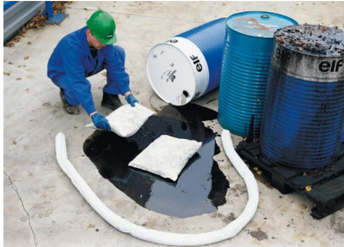
Figure 50 : Exemple d'élimination par absorbants à la suite d'une pollution accidentelle (INRS / 2008)
