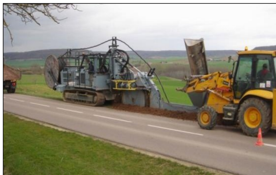
Figure 28 - Exemple de tranchée réalisée
