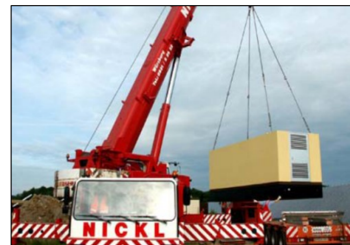
Figure 27 - Exemple d'acheminement d'un poste technique préfabriqué
