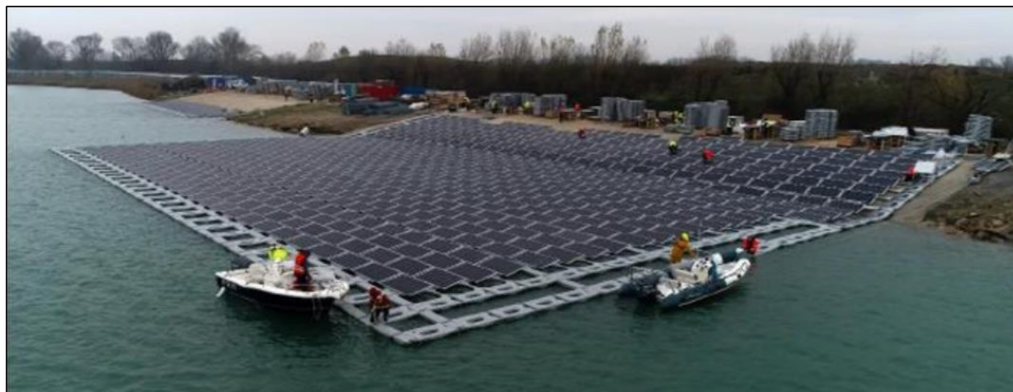
Figure 18 - Phase de mise à l'eau (Plan d'eau de Piolenc - 84, Ciel-et-Terre)
