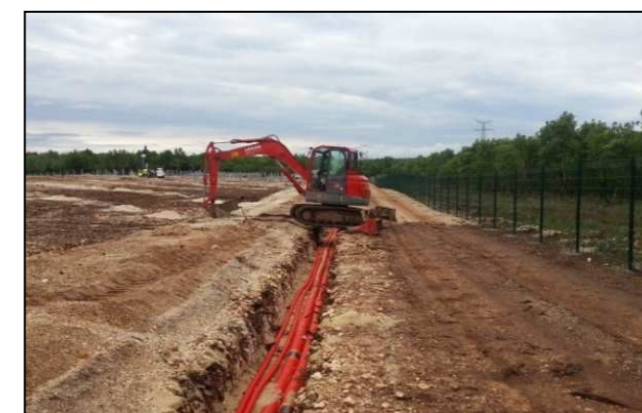
Figure 25 - Enfouissement des réseaux
