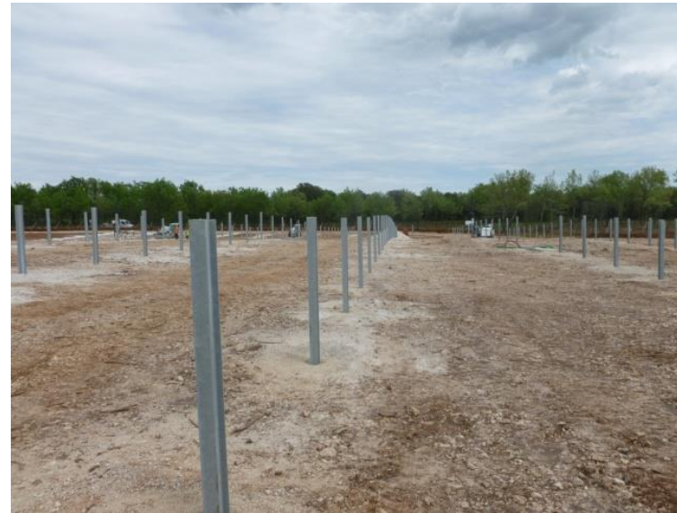
Illustration du chantier de création d'un parc photovoltaïque au sol avec pieux battus ou forés et bâtiments techniques
