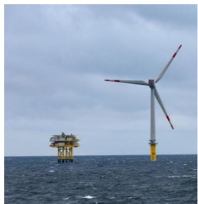
Cette technologie reprend le système de l'éolienne terrestre par la transformation de l'énergie cinétique du vent en énergie mécanique puis électrique, à l'aide de turbines. Cette technologie est la plus mature des EMR.
