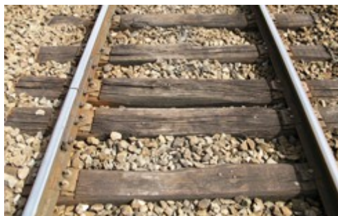
Rails courts sur traverses bois
