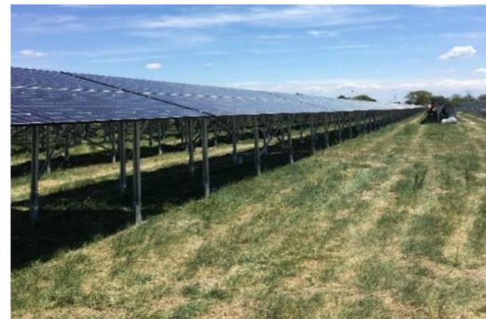
Figure 17 : Exemple de surélévation des panneaux sur la centrale au sol photovoltaïque de Salins-de-Giraud(13) avec un risque de submersion marine de 2 à 3m (source : URBASOLAR, 2021)
