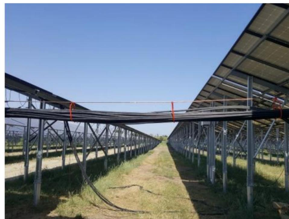
Figure 15 : Illustration des câbles courants laissés en aérien (source : URBASOLAR, 2021)
