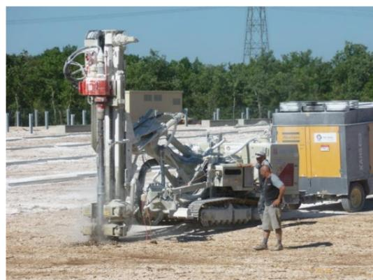
Figure 16 : Illustration de la phase de fixation des pieux battus (source : URBASOLAR, 2021)
