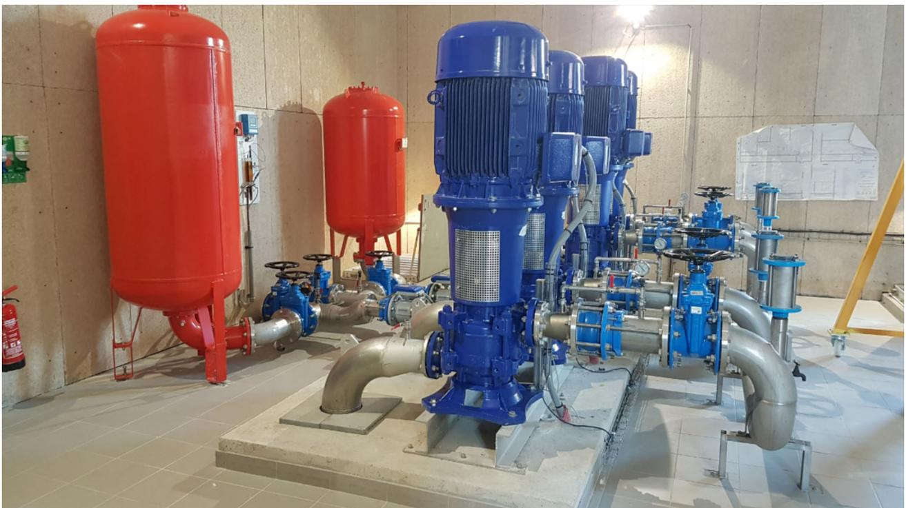
Figure 13 : pompes de refoulement vers les réservoirs + ballons anti-bélier associés.
