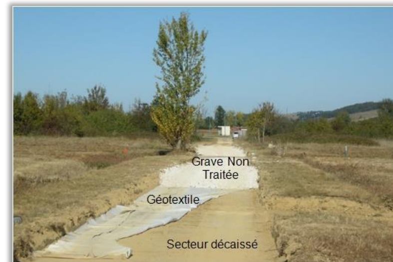
Mise en place d'une voie engins (interne)
