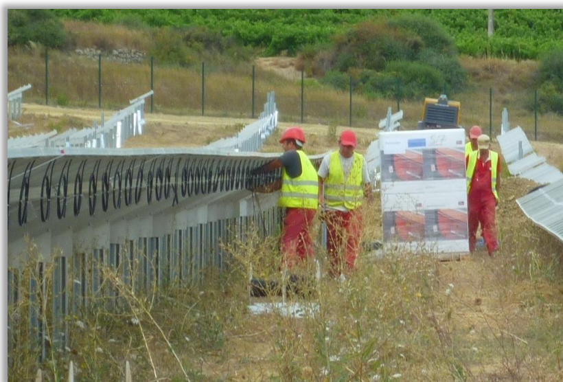
figure 15. Câblage et interconnexion des modules photovoltaïques
