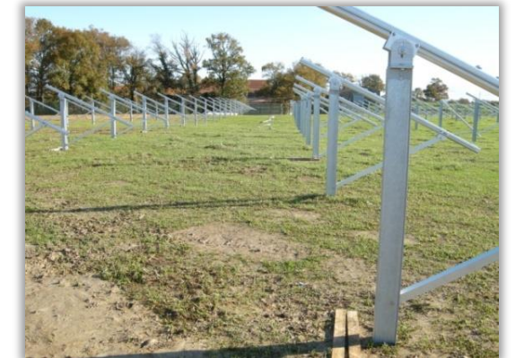
Structures prêtes à recevoir des modules
