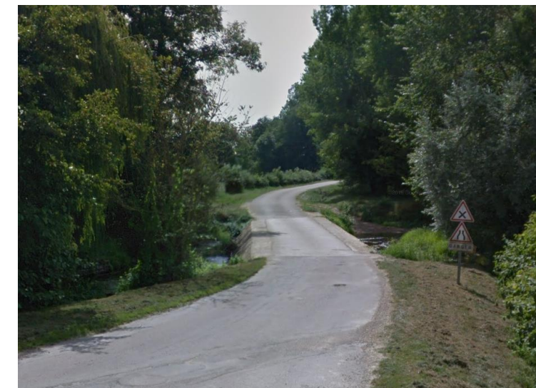
figure 123. Pont au bourg de Courterolles pour traverser la rivière du Serein (source : Google street view 2013)
