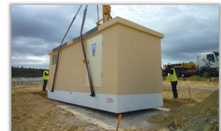
figure 27. Schéma de dépose des postes préfabriqués - Source : Transfix
