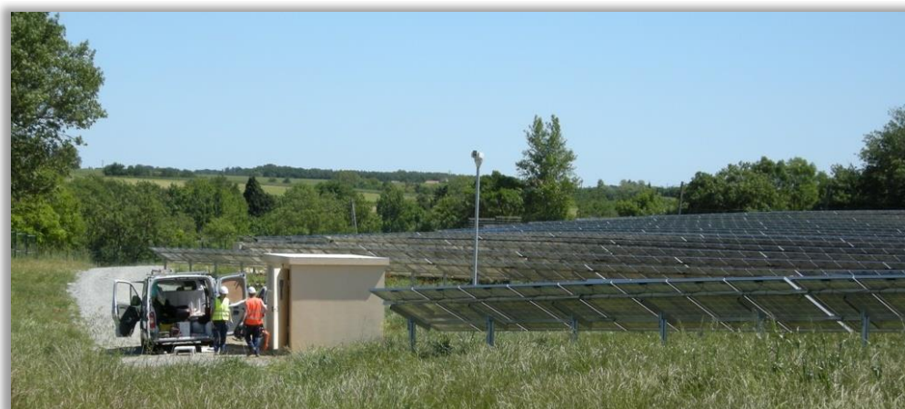
figure 29. Opération de maintenance
