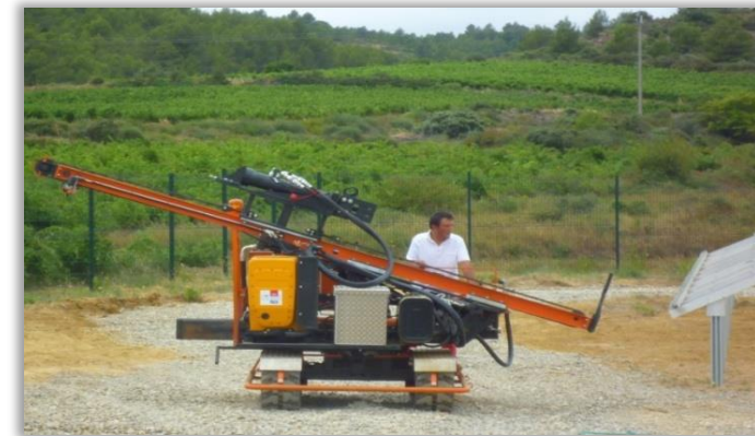
Machine de battage de pieux
