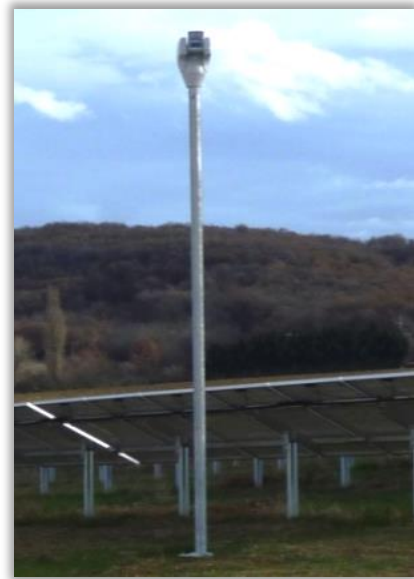
Mât de surveillance
