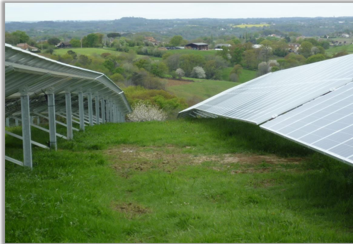
figure 10. Adaptation des tables à la topographie
