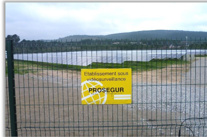
Signalétique de sécurité sur la clôture
