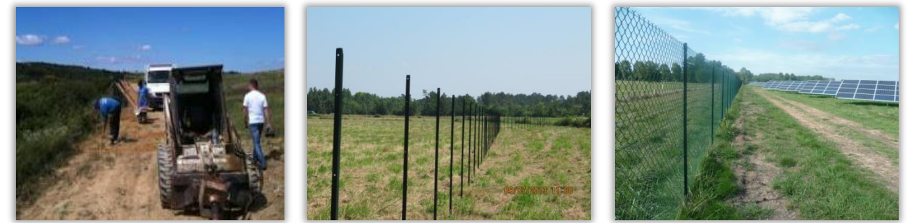
figure 19. Mixe en place de la clôture : pose des ancrages, des piquets et du maillage
