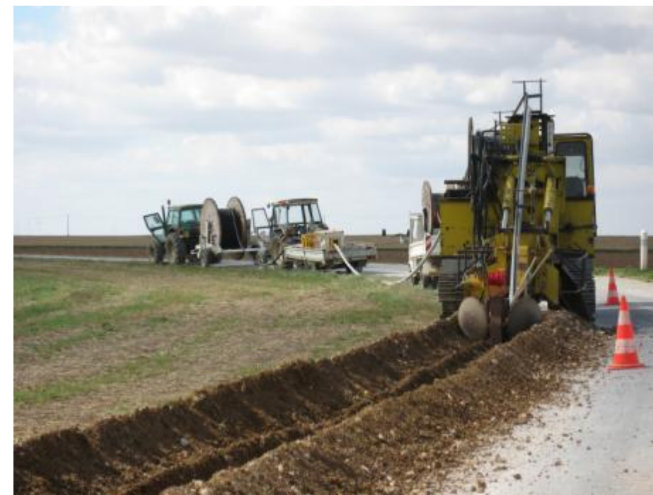
figure 120. Illustration des travaux de raccordement réalisés par ENEDIS (source : EDF Renouvelables)
