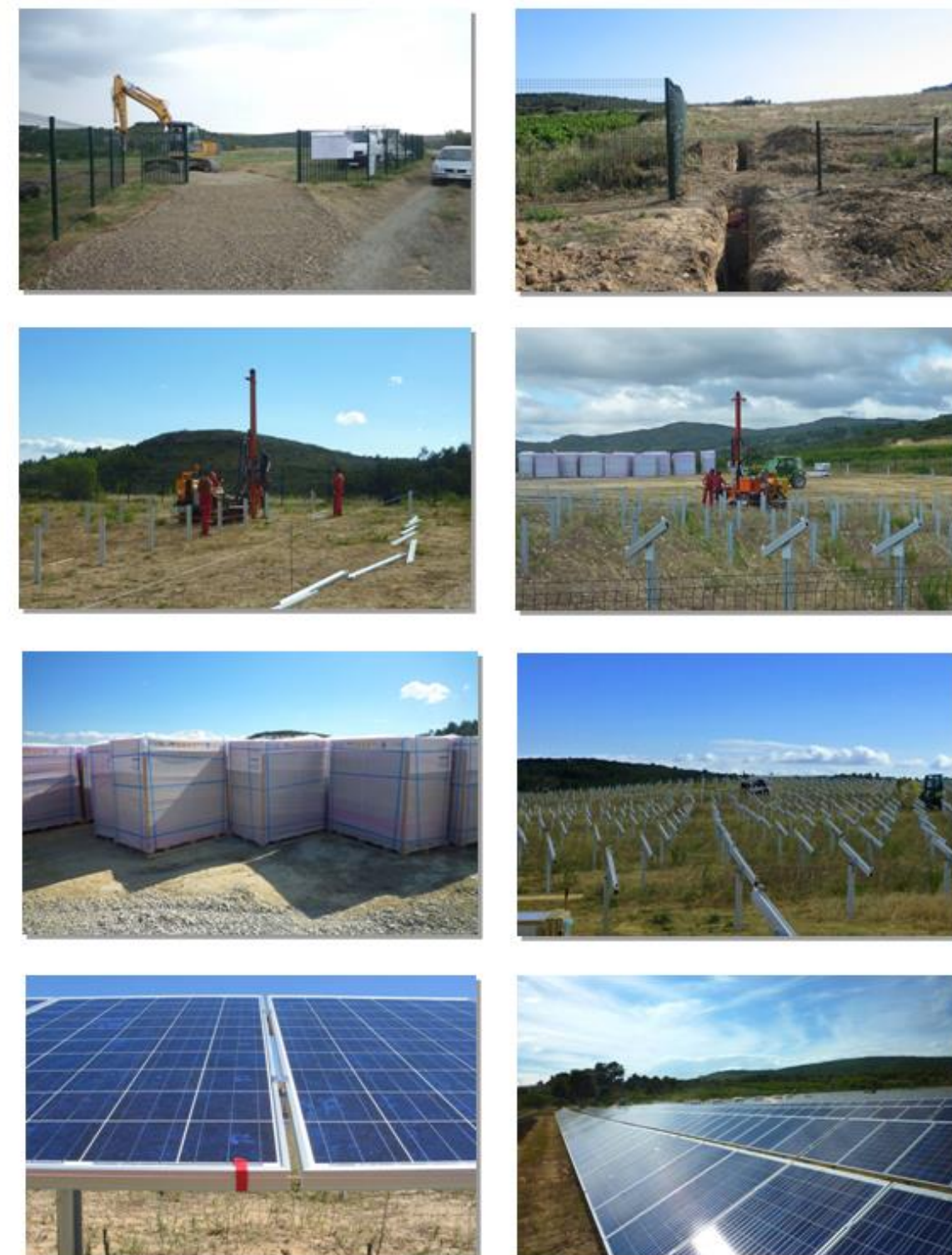
figure 28. Présentation des différentes étapes du chantier (Source : LUXEL)
