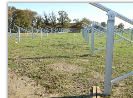
Structures prêtes à recevoir des modules
