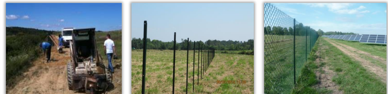
Mise en place de la clôture : pose des ancrages, des piquets et du maillage
