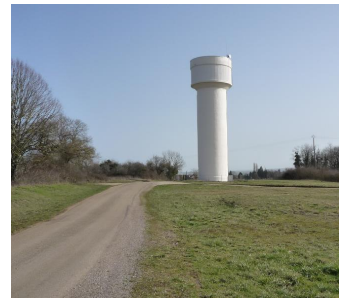
Figure 15. Château d'eau présent en bordure de la voie communale Les Pierrières – Source : Luxel, 2021
