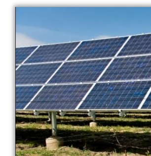
sur plots béton
