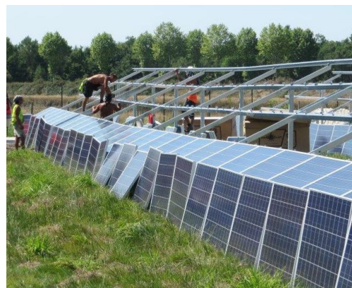
Pose manuelle des modules - Source : Luxel
