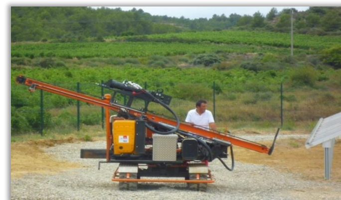
Machine de battage de pieux
