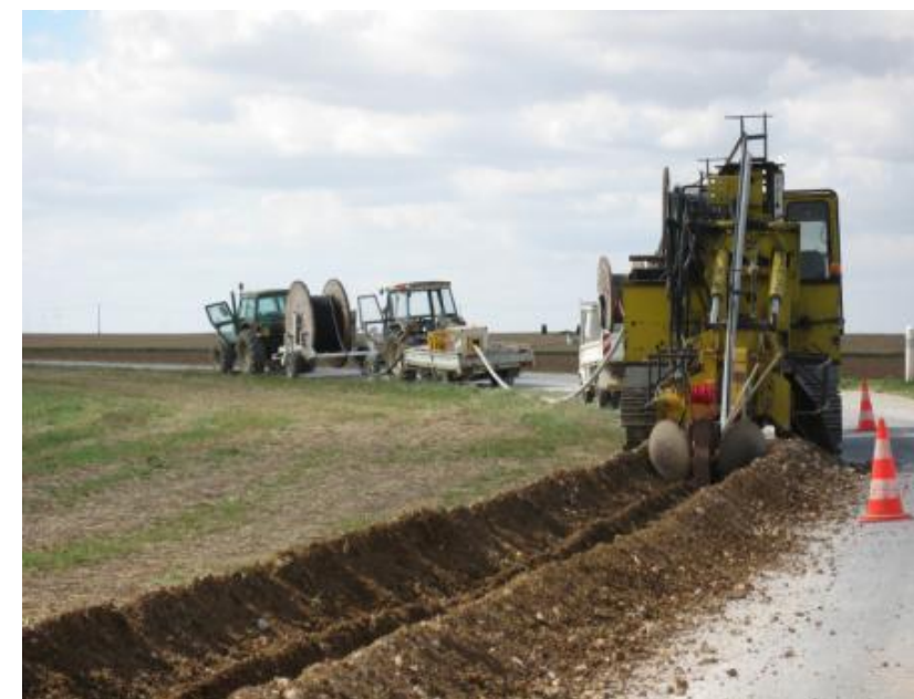
Figure 25. Illustration des travaux de raccordement réalisés par ENEDIS (source : EDF Renouvelables)
