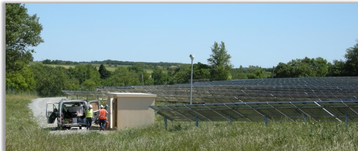
Opération de maintenance
