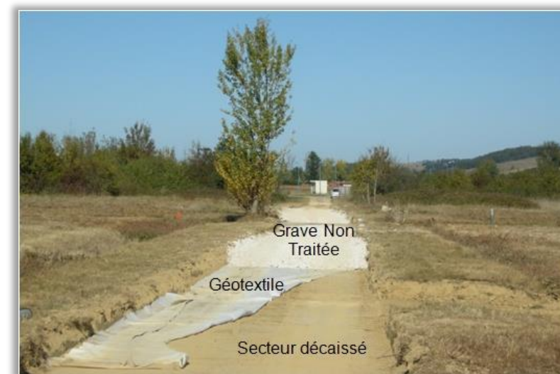
Mise en place d'une voie engins (lourde)
