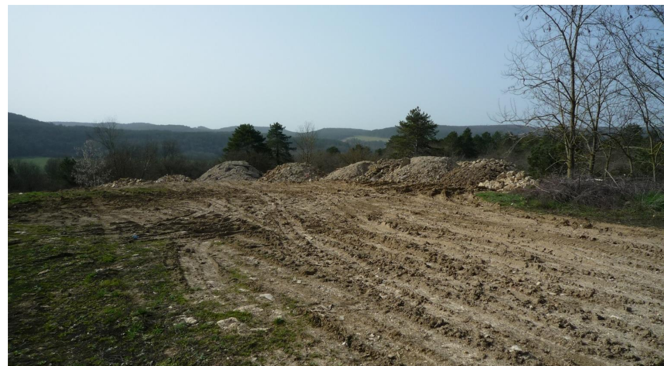
(2) Vue sur la zone de dépôt de gravats
