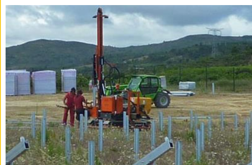
Battage des pieux
