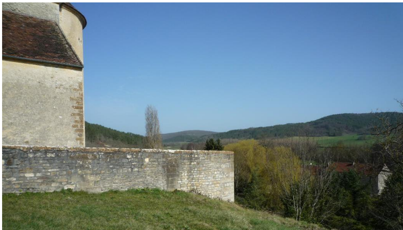
(51) Vue en direction de l'aire d'étude depuis l'église Saint-Jacques-le-Majeur
