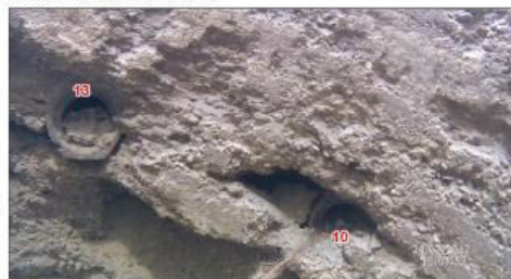
Vue sur les drains 13 et 10
