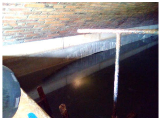
Prolongement de la cuve sous l'arche
