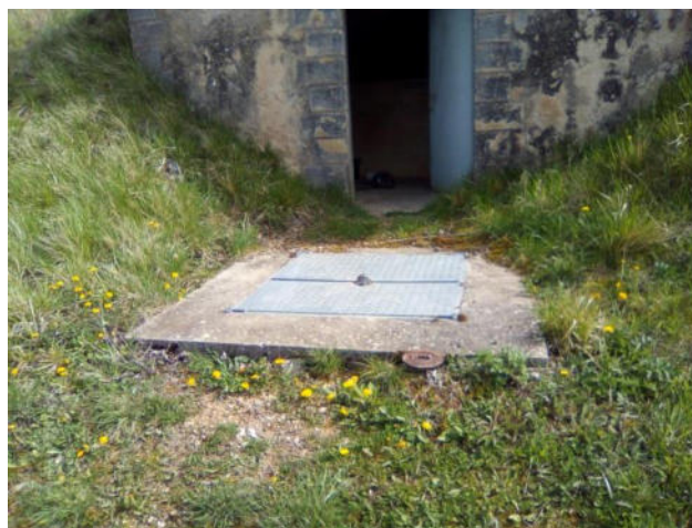
Accès à la chambre de vannes
