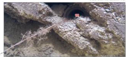
Vue sur le drain 10
