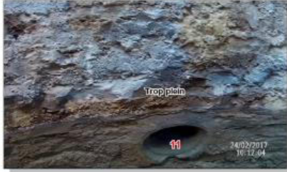
Vue intérieure de l'ouvrage
