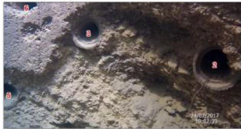
Vue sur les drains 5, 6, 3 et 2
