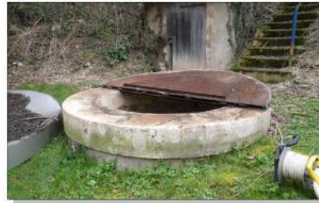
Vue extérieure de l'ouvrage
