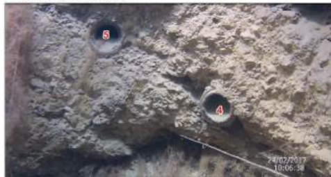
Vue sur les drains 5 et 4
