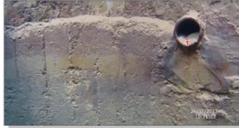
Vue sur le drain 1
