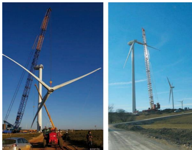
Figure 27 : Montage du rotor (à gauche), montage « pale par pale » (à droite)
