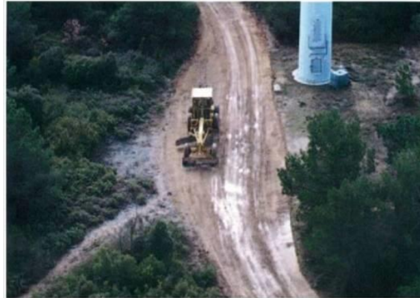
1 - Début des travaux et préparation des accès
