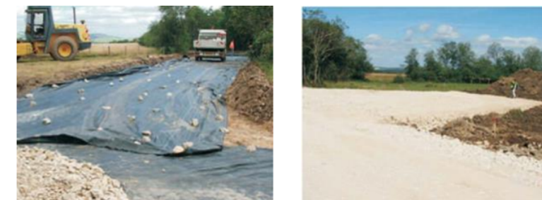
Figure 26 : Pose d'un géotextile (à gauche), état final d'une plate-forme (à droite)
