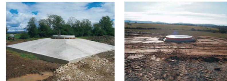
Figure 25 : Massif béton terminé (à gauche), état final après remblaiement (à droite)
