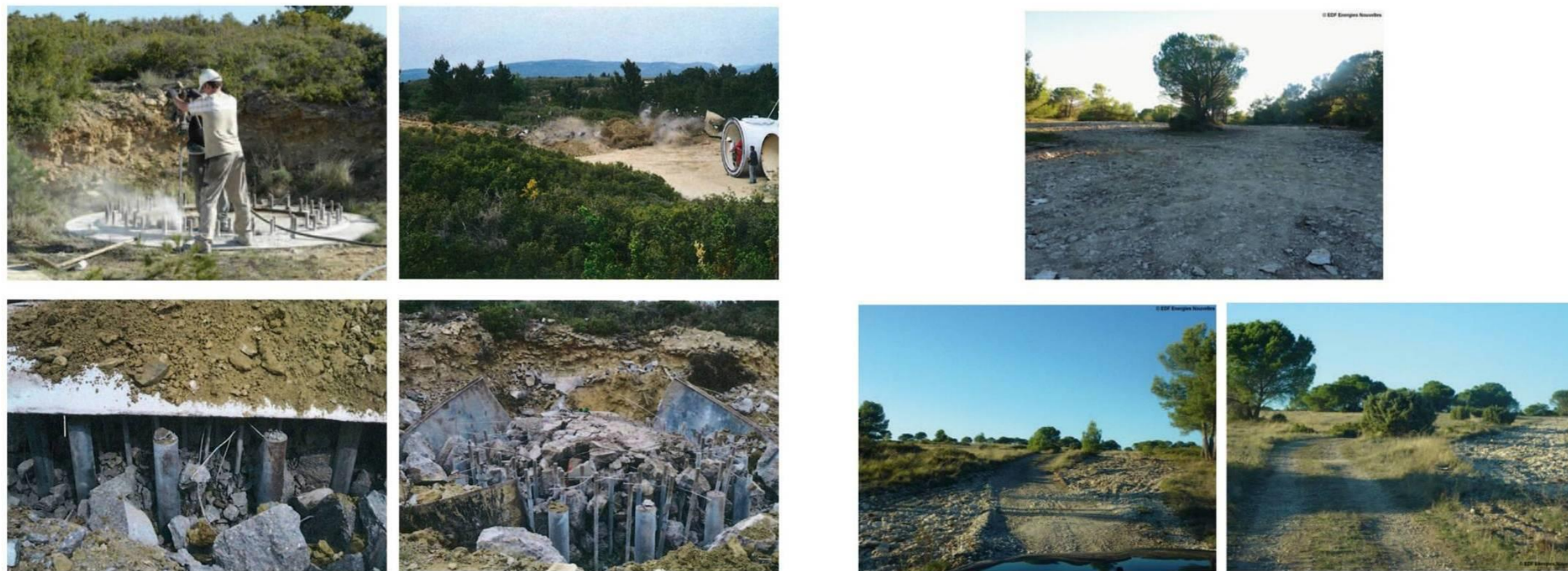
8 - Mise en place et mise à feu des explosifs pour destruction des fondations et évacuation vers les filières adaptées de gestion des déchets
