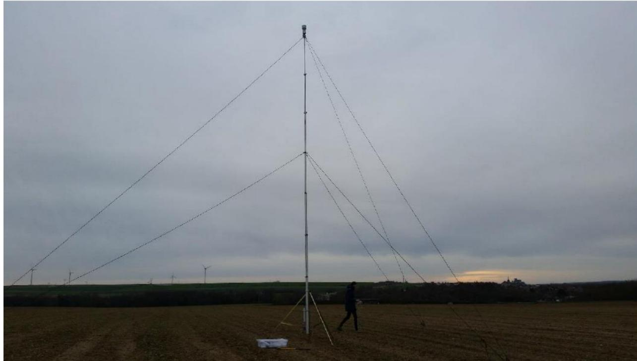
Figure 10 : mise en place du mât météorologique
