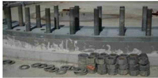
Photo 68 : Détail des fixations de la fondation
