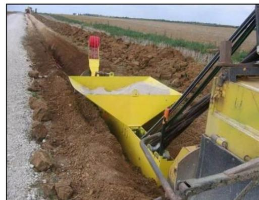
Photo 72 : Engin utilisé pour le creusement de la tranchée et la pose des câbles
