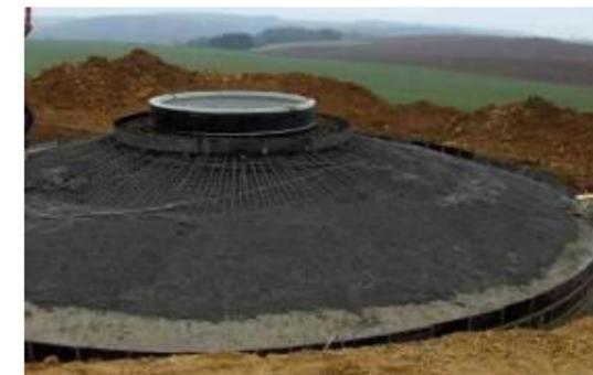
Photo 66 : Exemple de ferrailage en radier pour une éolienne
