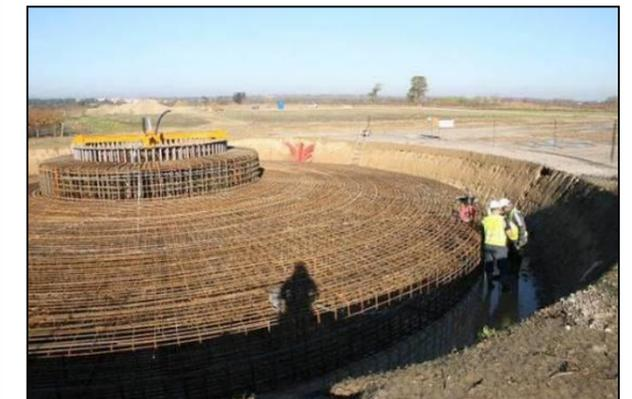
Photo 77 : Ferrailage de la fondation
