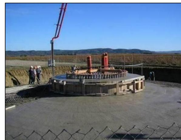
Photo 78 : Coulage du béton
