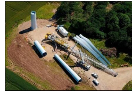
Photo 83 : Vue d'ensemble des étapes d'assemblage de la tour (exemple de tour en acier)
