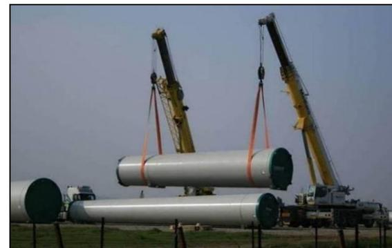
Photo 81 : Manipulation des tronçons d'éoliennes
