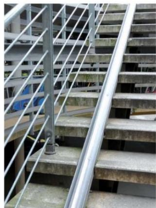
Figure 28 : Exemple d'aménagement de gouttière permettant de monter un vélo sur une passerelle dotée d'un escalier
