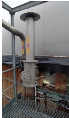
**Figure 7 Représentation d'une soupape de sécurité**
