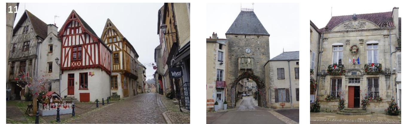
Figure 27 : Maisons à colombages et patrimoine urbain de la commune de Noyers (source : Résonance Urbanisme et Paysage)
