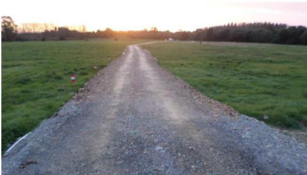
Piste d'accès au PRA du Meleuc réalisée en 2015
