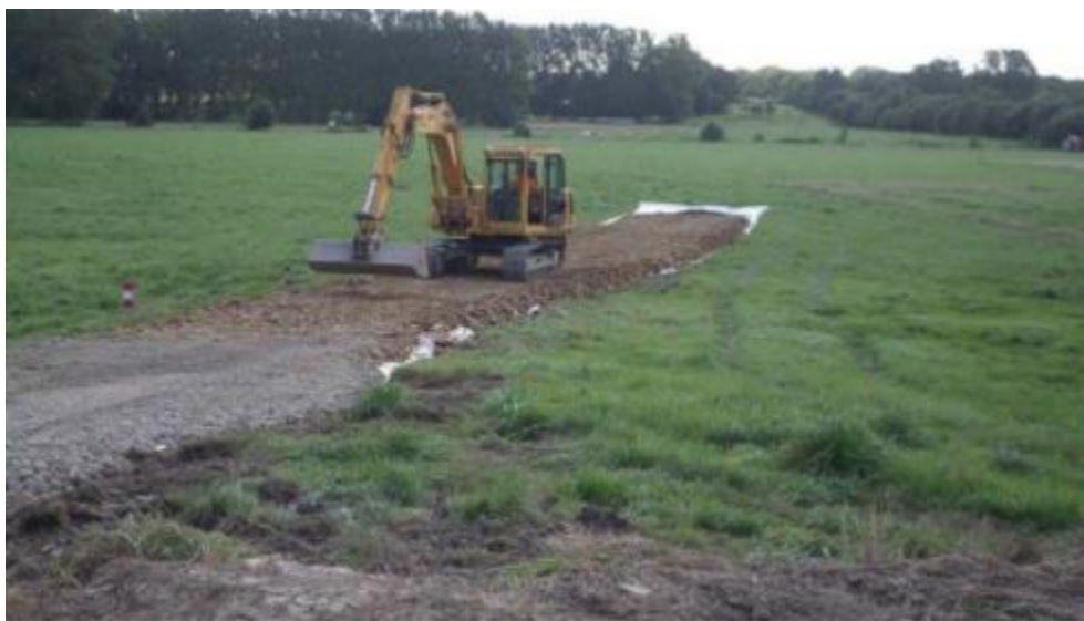
Réalisation de la piste d'accès au PRA du Meleuc en 2015
