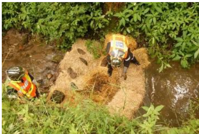
Exemple de mise en place de bottes de pailles dans un cours d'eau (DNA)
