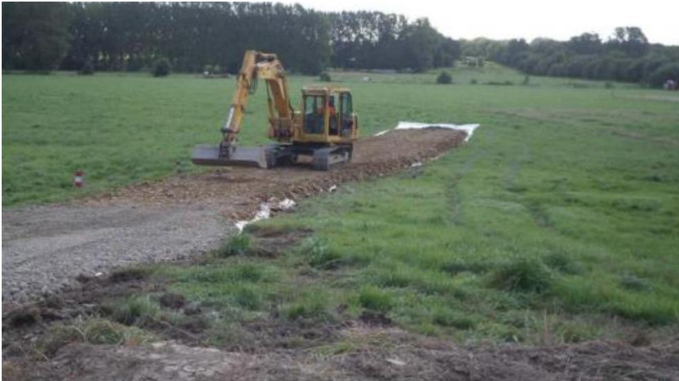
**Figure 47 : Réalisation de la piste d'accès au PRA du Meleuc en 2013**
