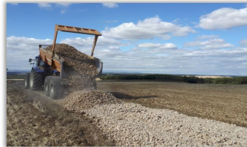
Chemin en cailloux broyés collectés sur les parcelles du projet
