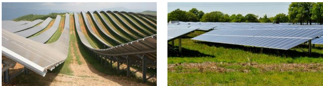
Figure 243. A gauche : Exemple d'adaptation au terrain (source : Mairie Les Mées) ; à droite : Exemple de vue proche (source : ENCIS Environnement)
