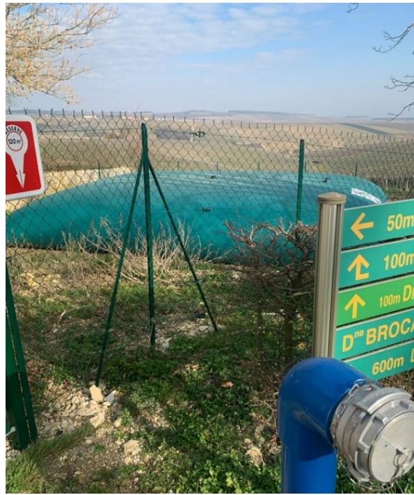
Figure 60. Citerne souple avec colonne d'eau
