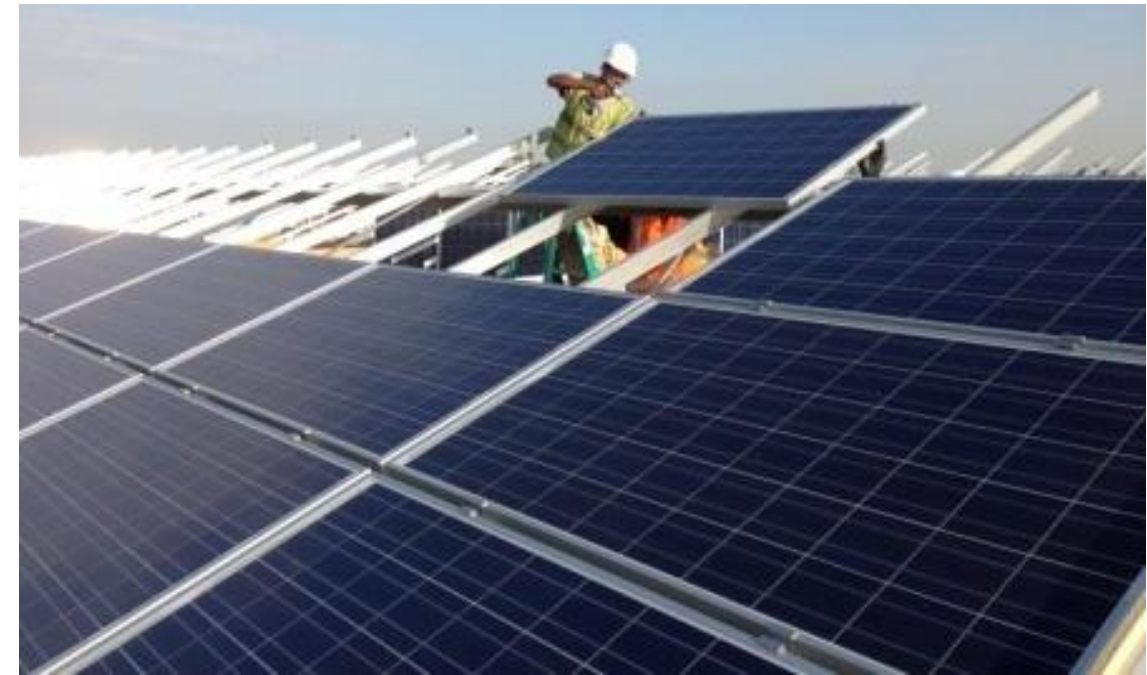
Figure 63. Exemple de mise en place des modules sur les structures
