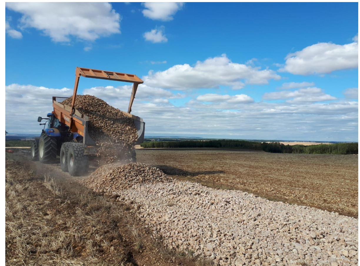
Figure 56. Opération de collecte et de broyage de cailloux, puis création d'une piste à partir des cailloux collectés.
