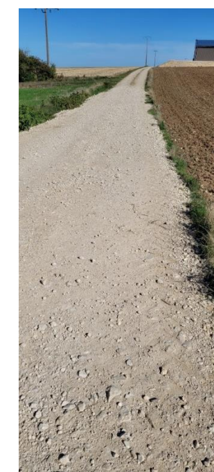
Figure 206. Exemple d'une piste, ici à Balnot-la-Grange (Aube)- créé à partir de cailloux collectés sur les parcelles (ici les cailloux ont été finement broyés et compactés relativement forts).
