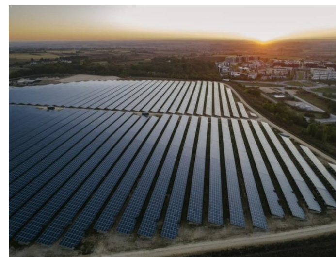
Figure 195. Centrale photovoltaïque de Dijon-Valmy, mis en service par EDF Renewables en 2021 (@EDF)
