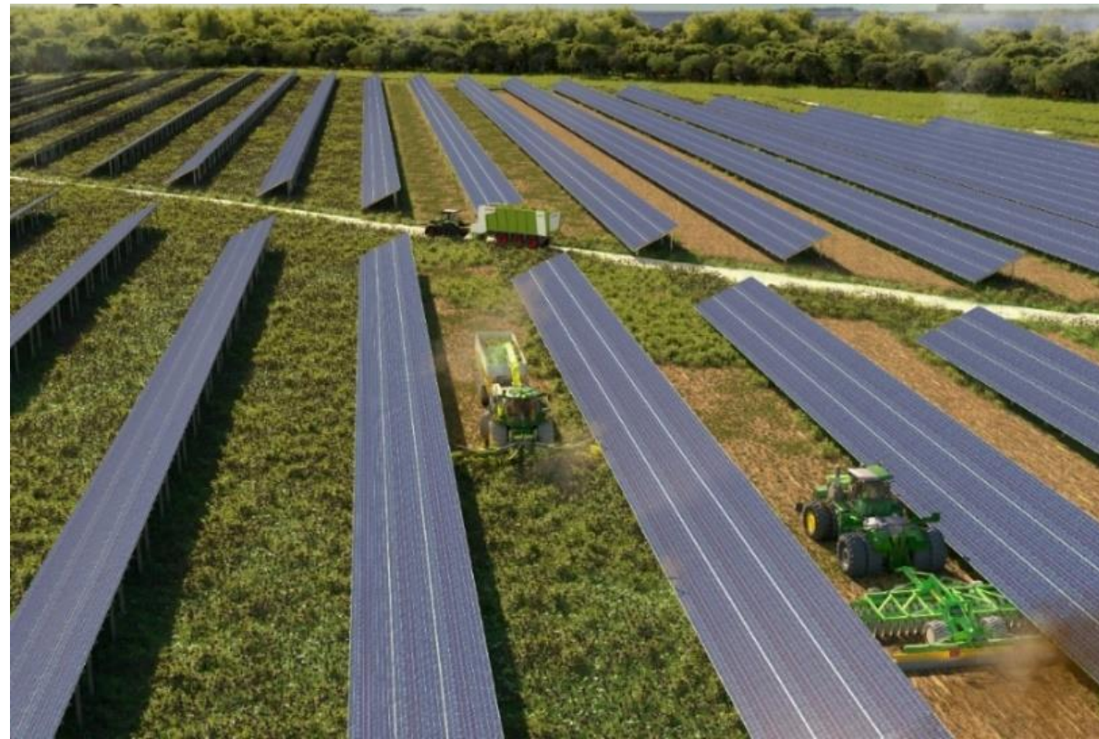
Figure 6. Production agricole en inter rangs au sein d'une ferme agrivoltaïque à structures fixes
