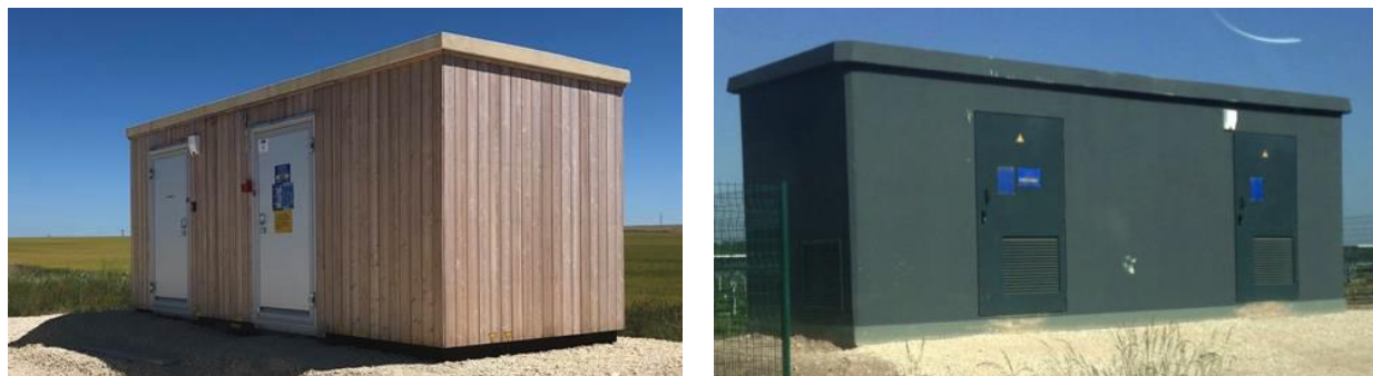
Figure 54. Local HTA en bardage bois et en teinte vert fougère
