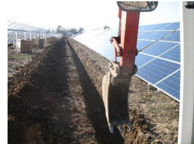
Figure 64. Exemple de tranchée entre deux tables photovoltaïques
