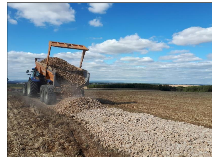
Figure 20. Opération de collecte et de broyage de cailloux, puis création d'une piste à partir des cailloux collectés.
