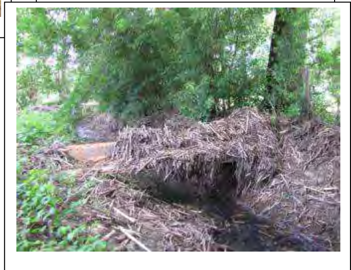
accumulation des cannes de maïs sur le fossé affluent à la Thalie suite à l'inondation du 4 novembre 2014
