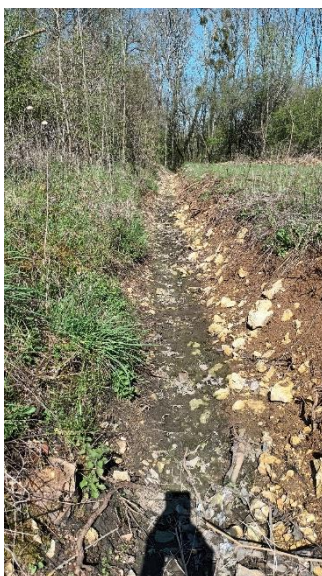
Figure 10 – Fossé actuellement en place pour l'évacuation des eaux de la plateforme, on devine la rupture de pente vers la partie boisée de la parcelle qui situe au nord-ouest du site
